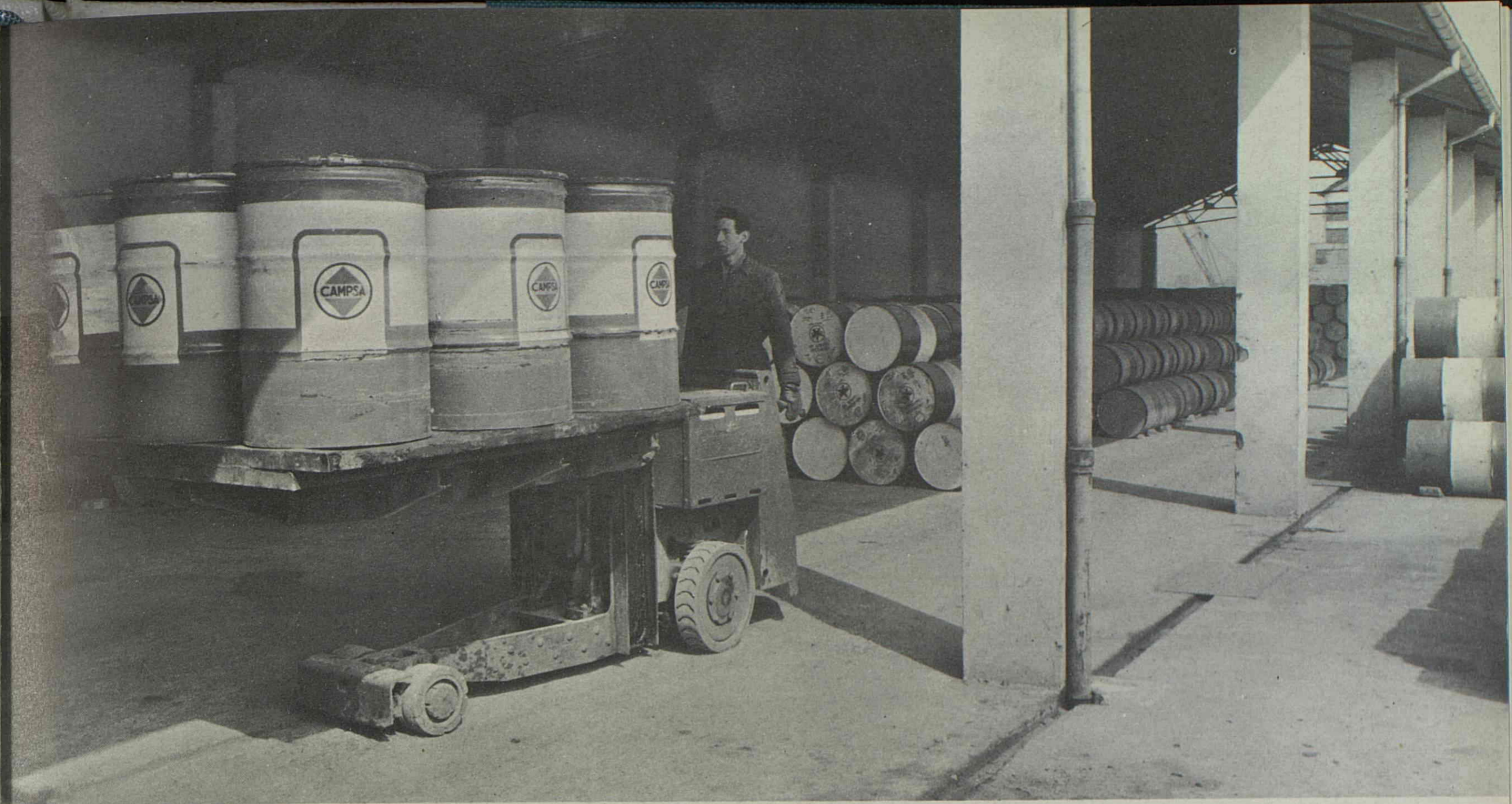
Almacenamiento de lubricantes. Zorroza (Bilbao)
