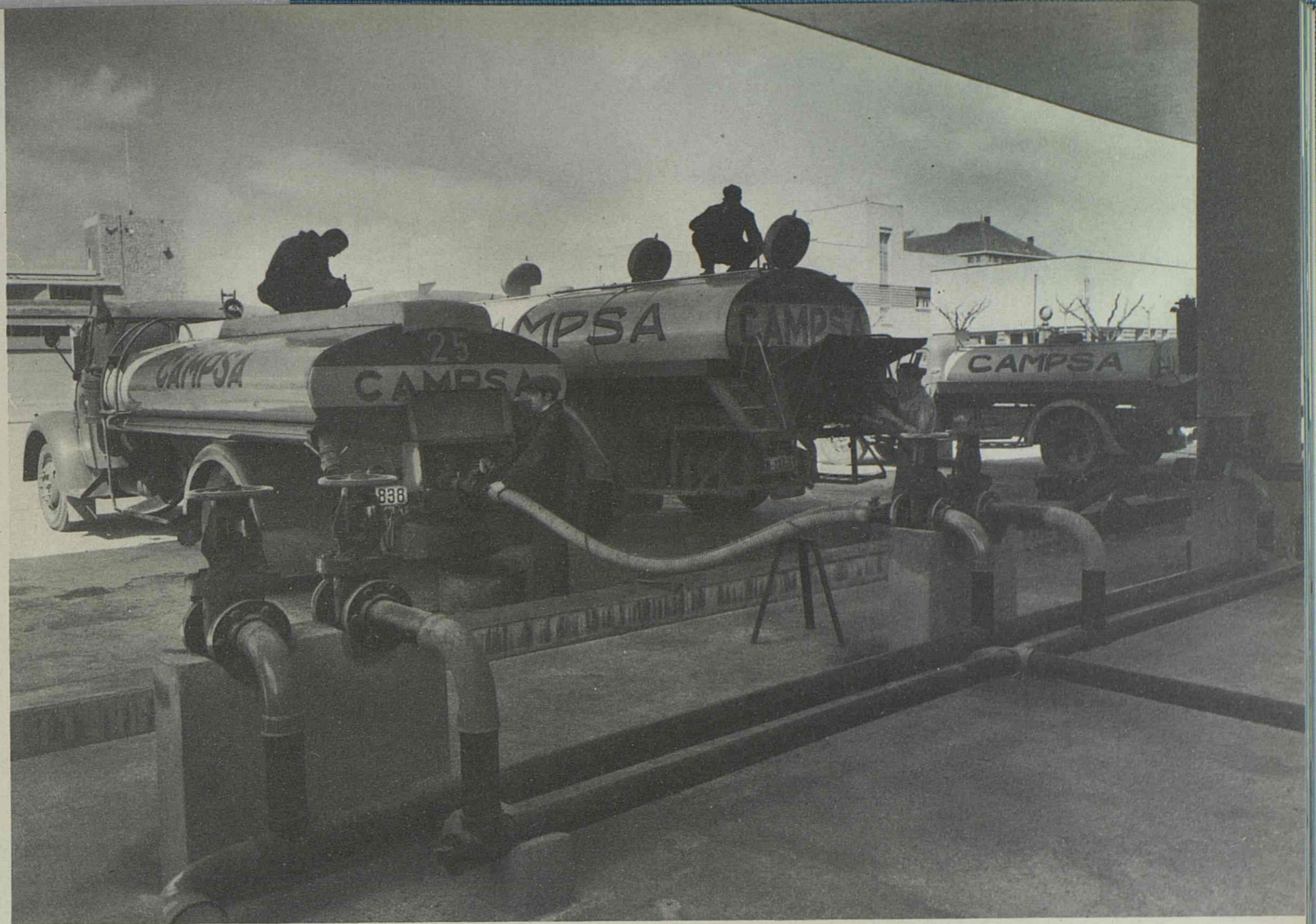
Carga de camiones cisterna, Valladolid
