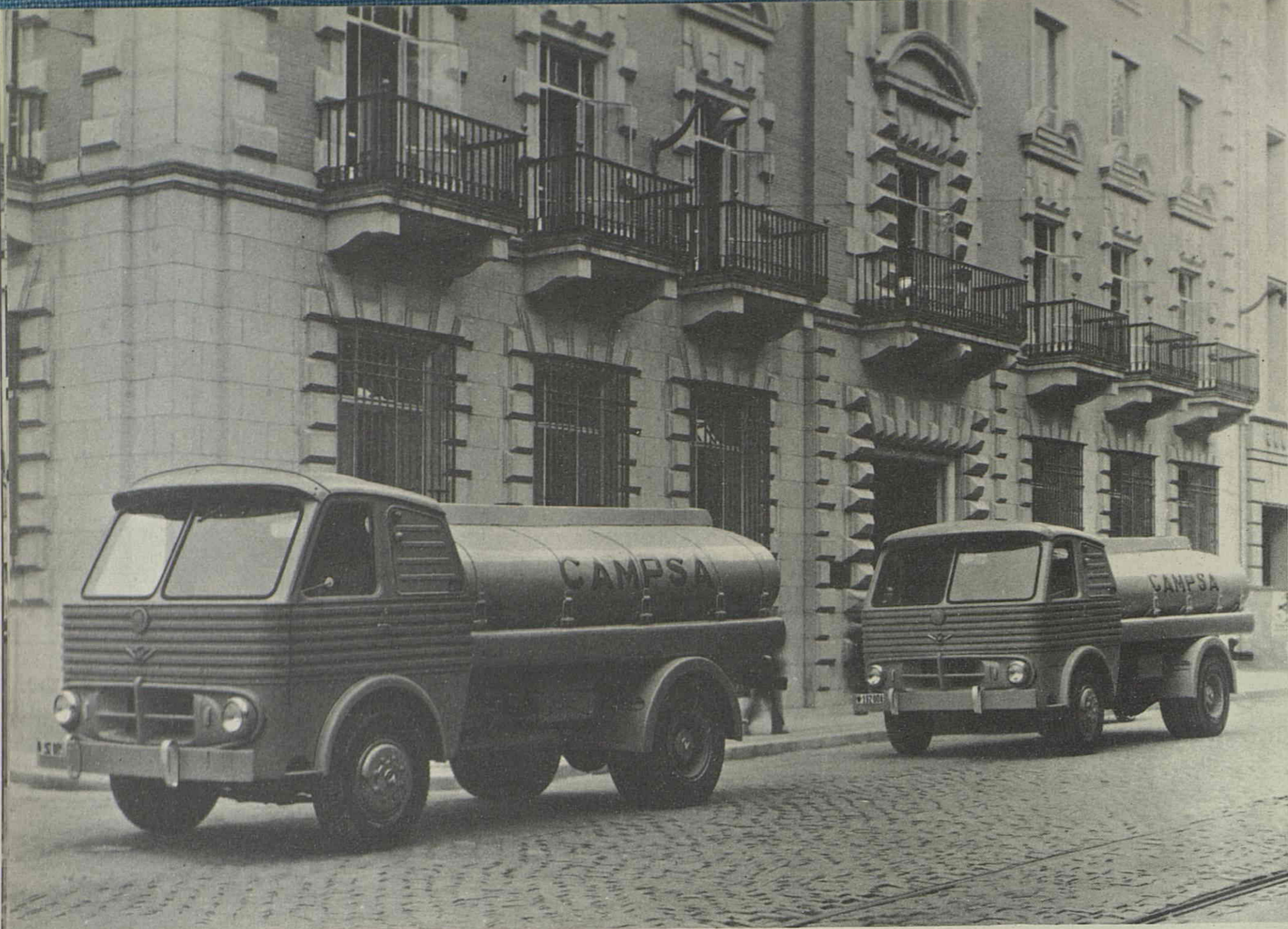
Nuevos camiones cisterna "Pegaso".
