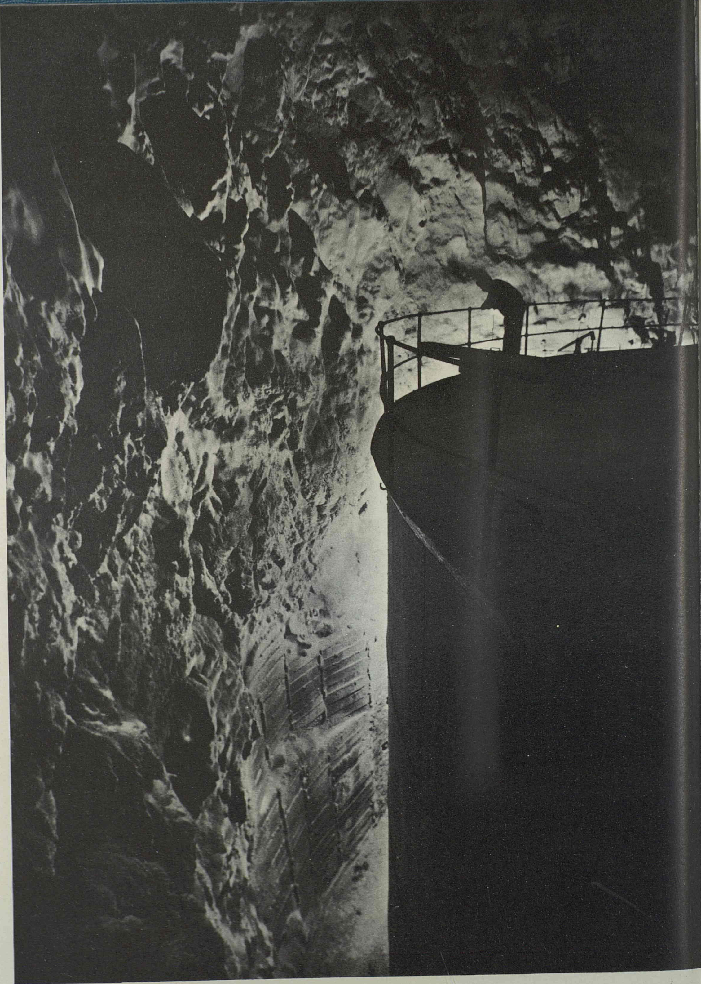
Tanque subterráneo de 2.000 m 3 en la factoría de Alicante.
