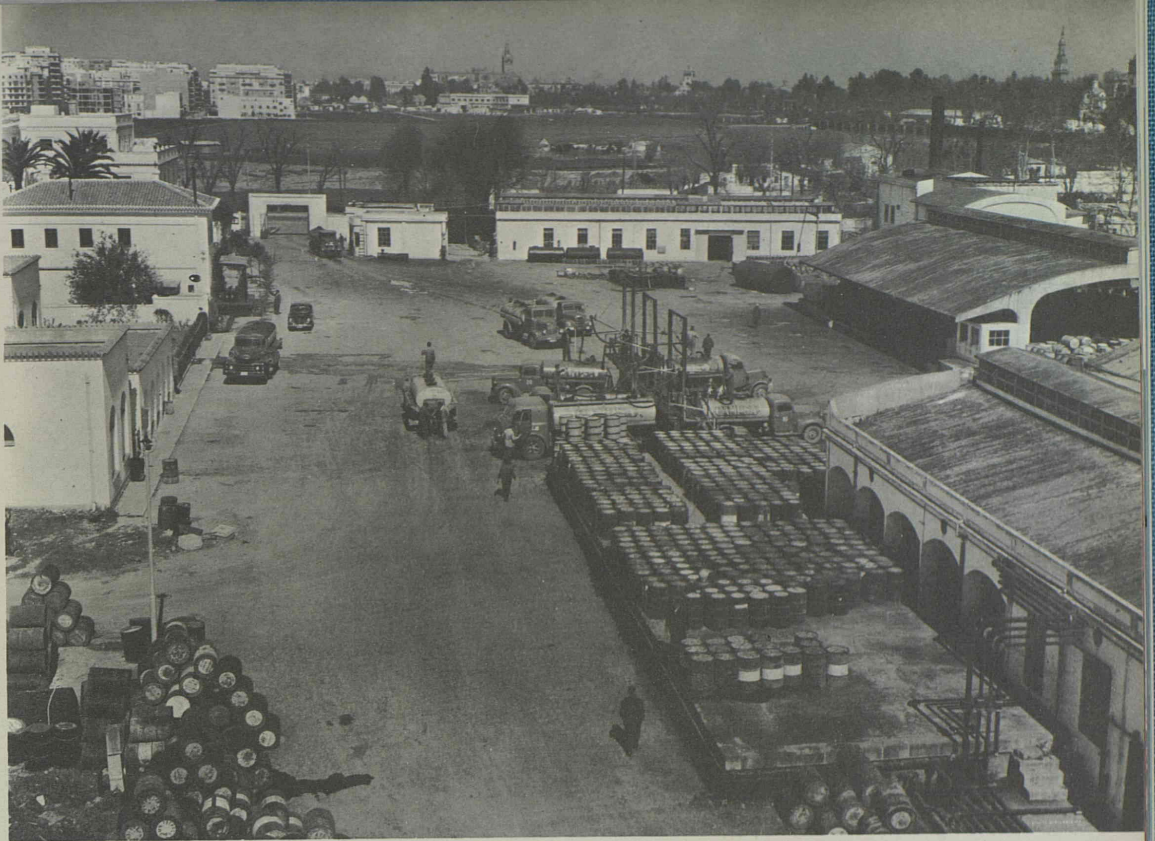
Vista parcial del patio de carga en la factoría de Sevilla.
