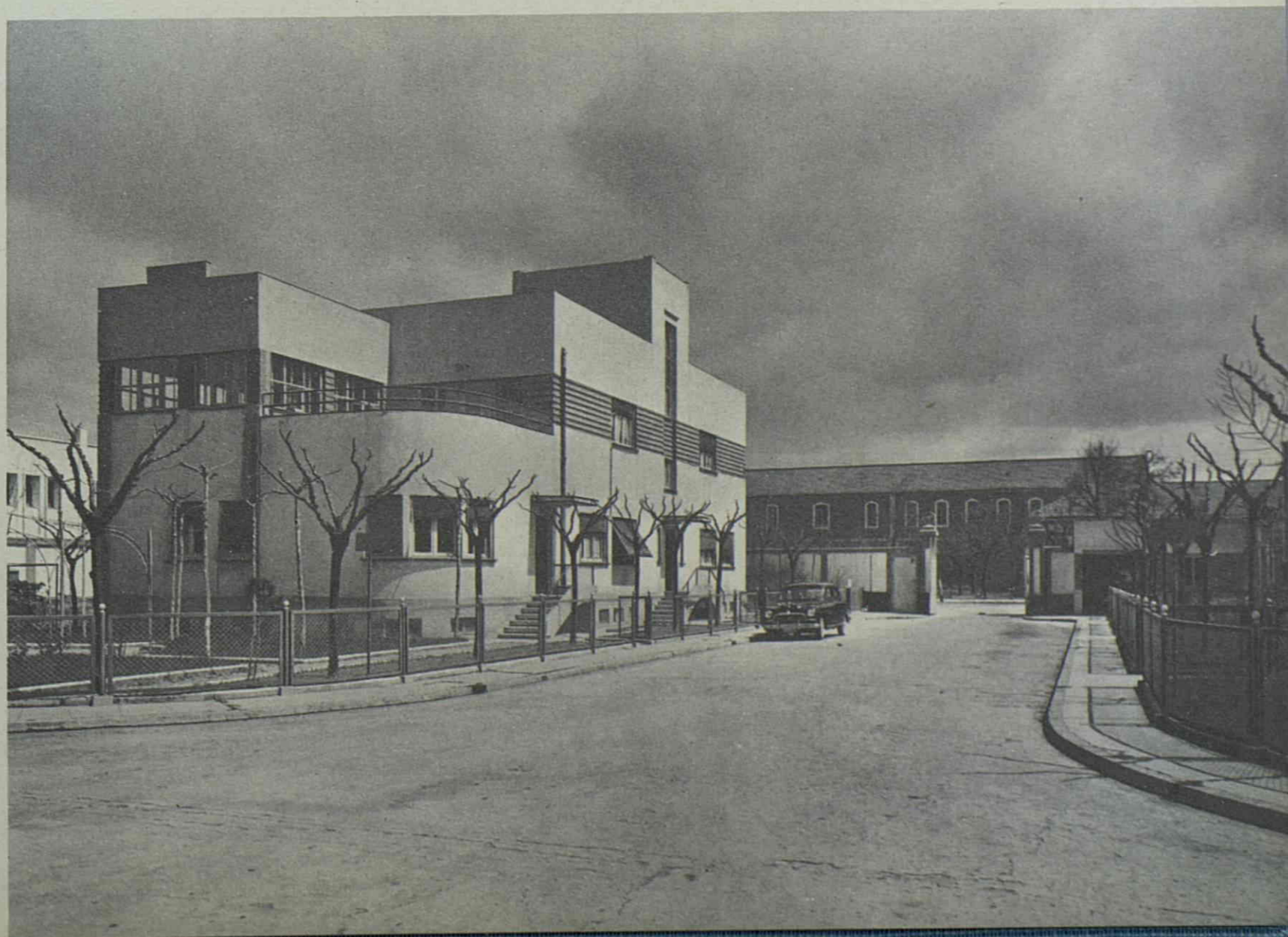
Acceso a la subsidiaria de Valladolid.
