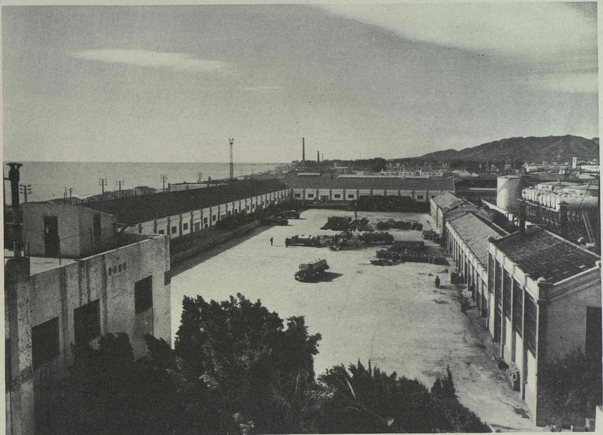
Vista general del patio de la factoría de Málaga.
