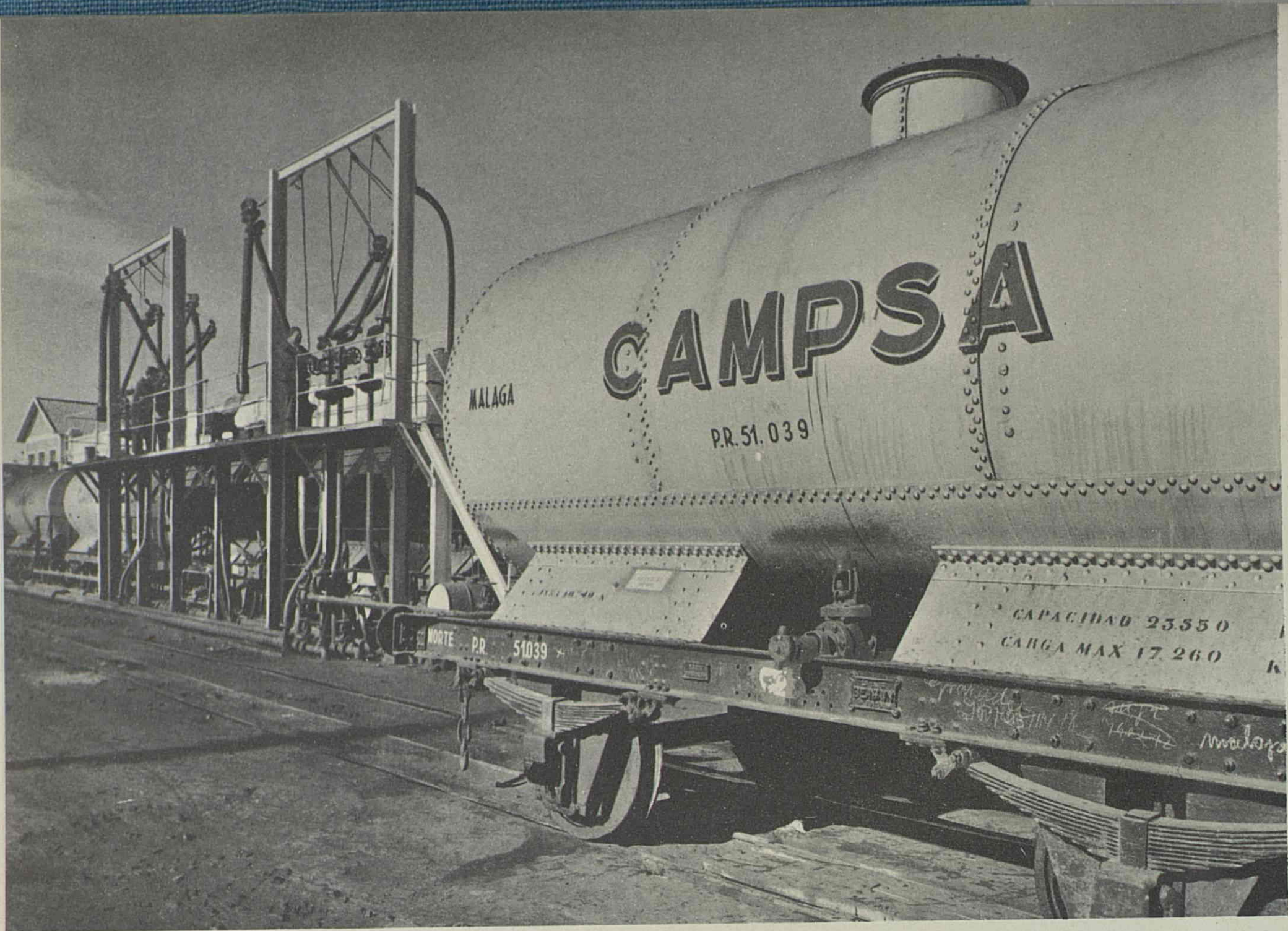
Vagón cisterna en el apartadero de Málaga.
