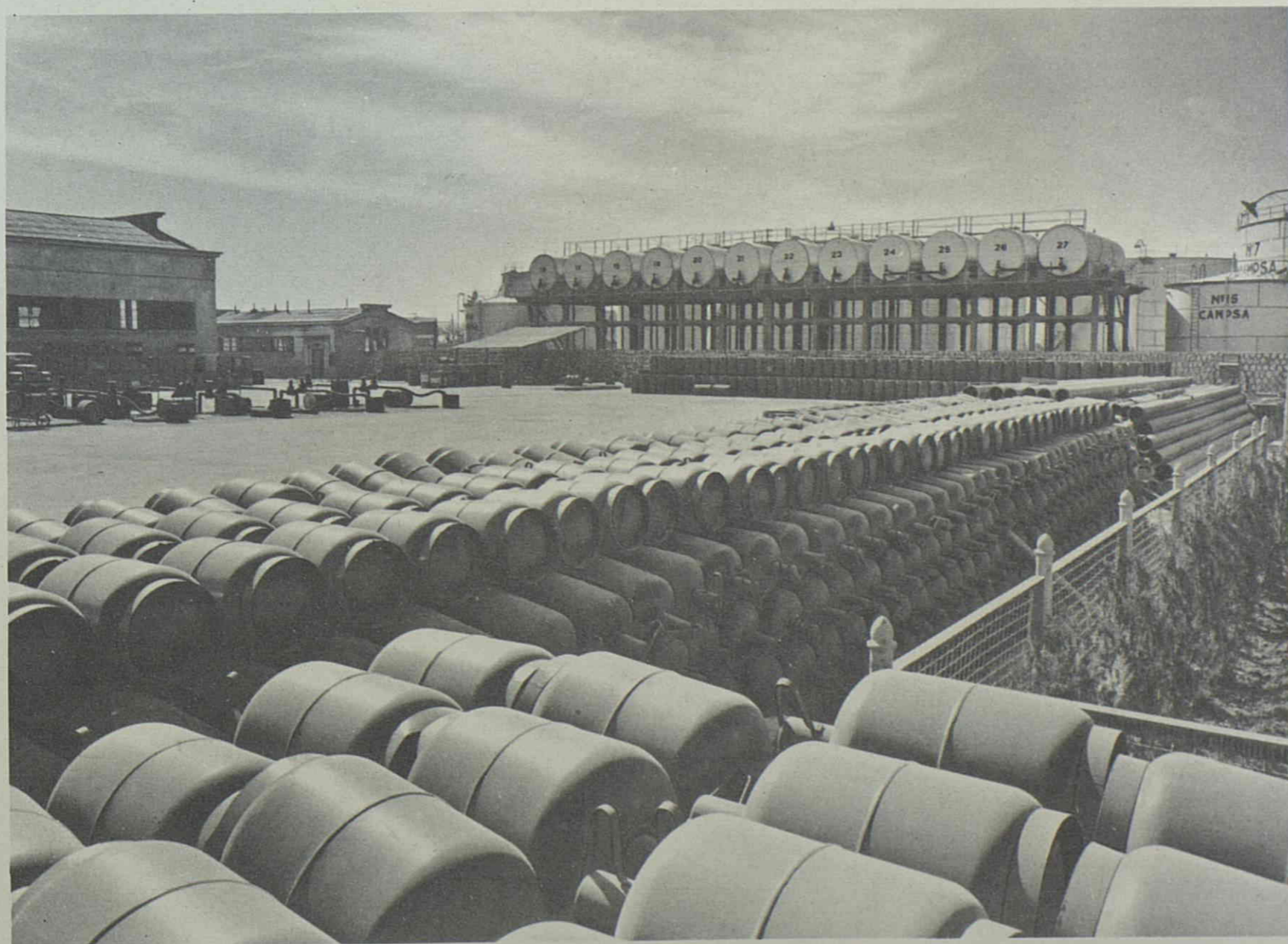
Patio de carga y castillete de tanques.
