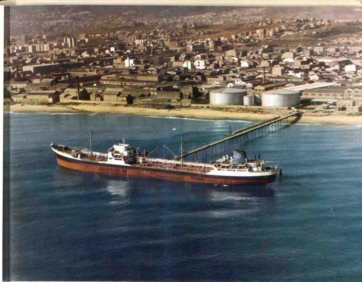
Pantalán e Instalación portuaria. - Badalona
