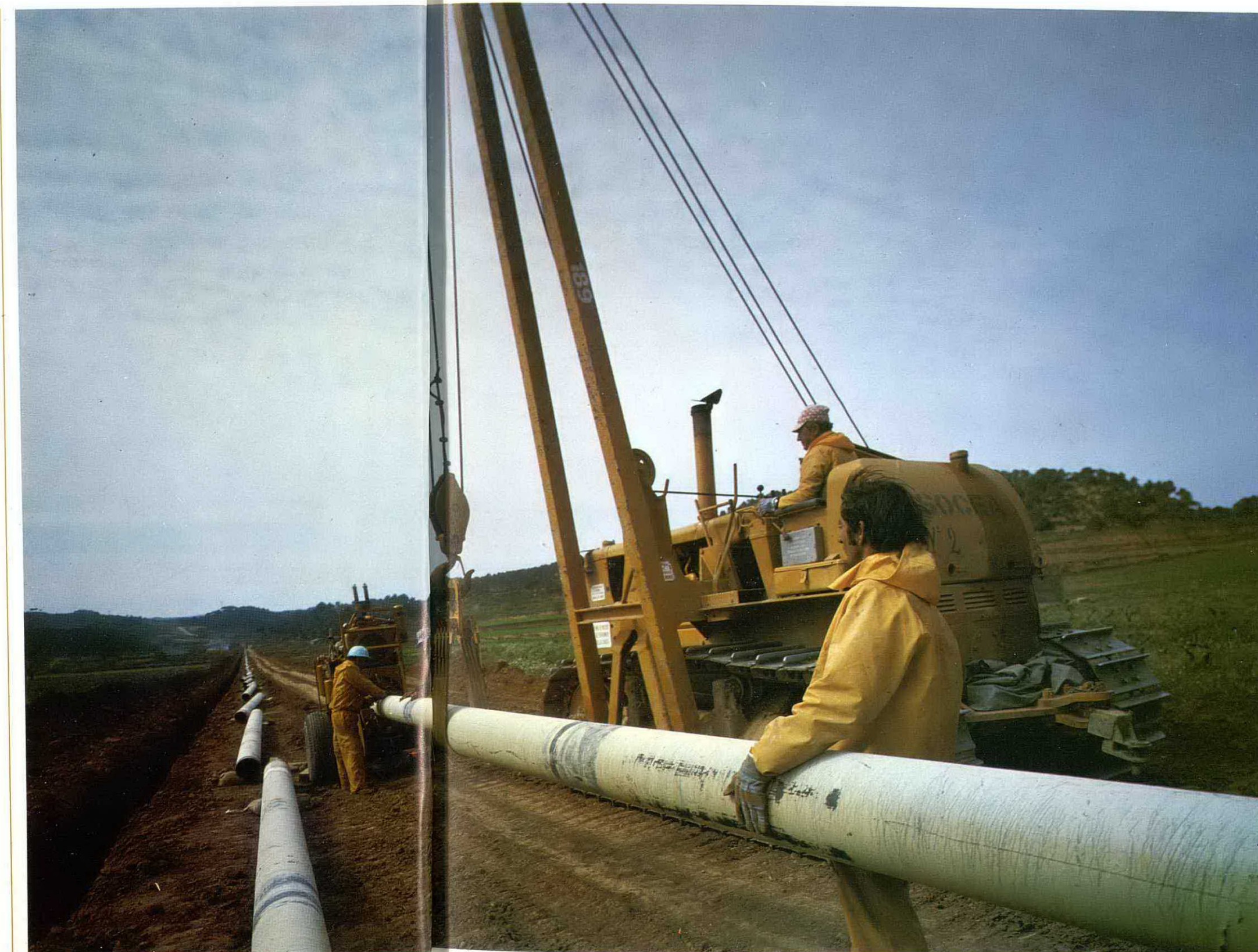
Montaje del oleoducto Tarragona-Zaragoza.
