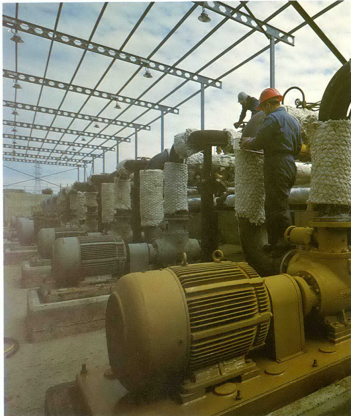
Montaje de la estación de descarga de vagones-cisterna. Torrejón de Ardoz.
