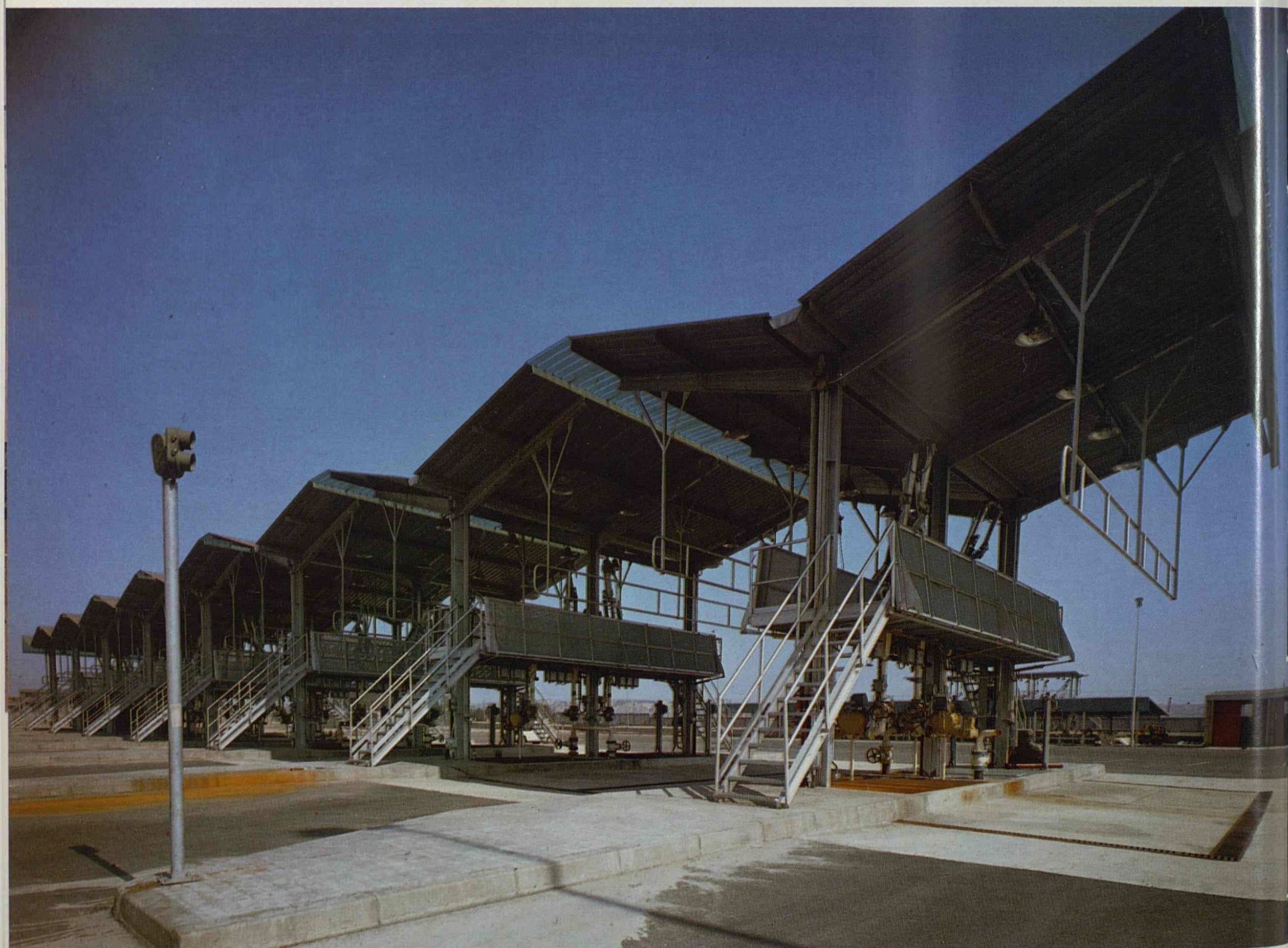
Cargadero de camiones cisterna
