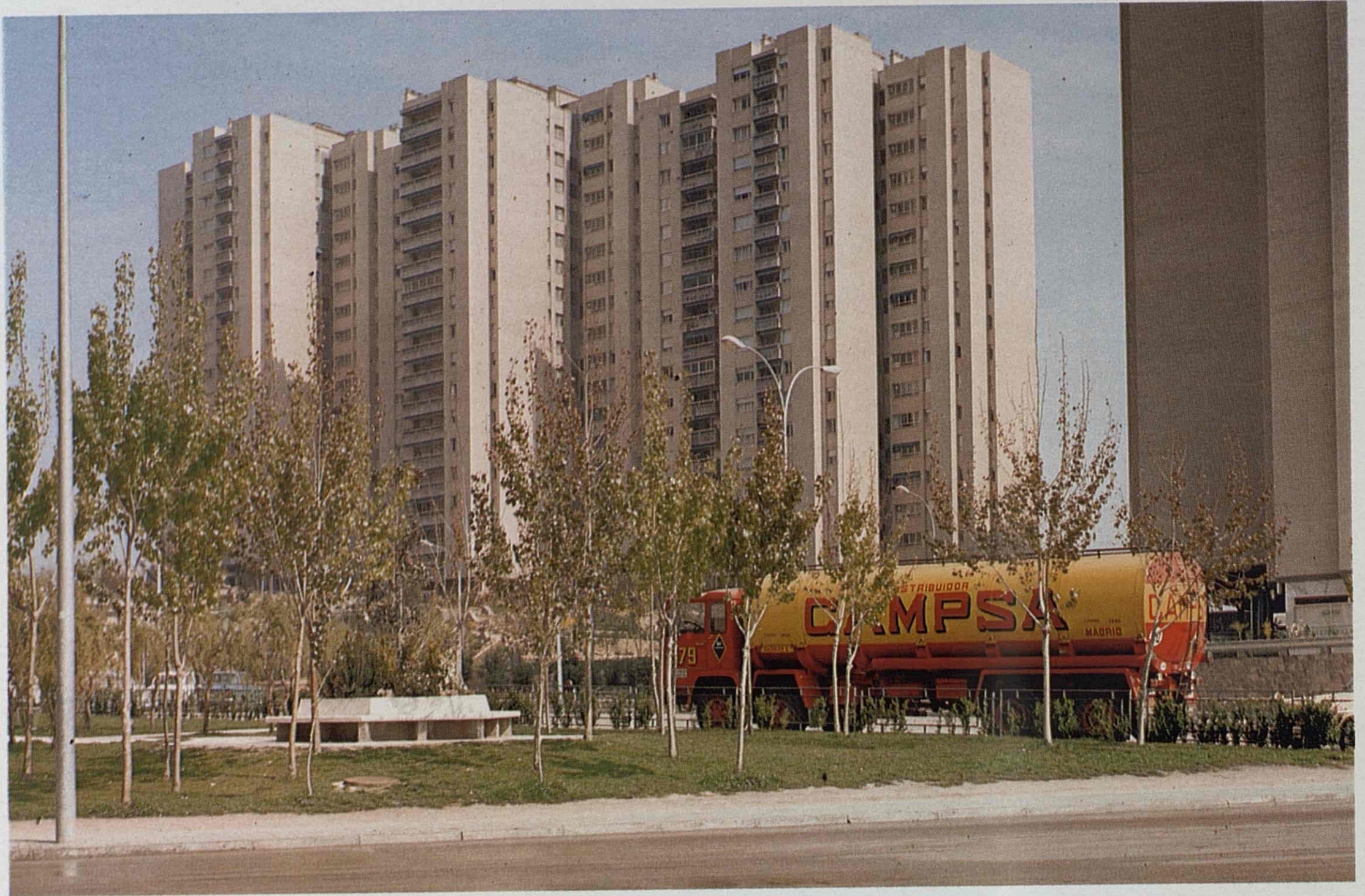
Suministro de combustible para calefacción
