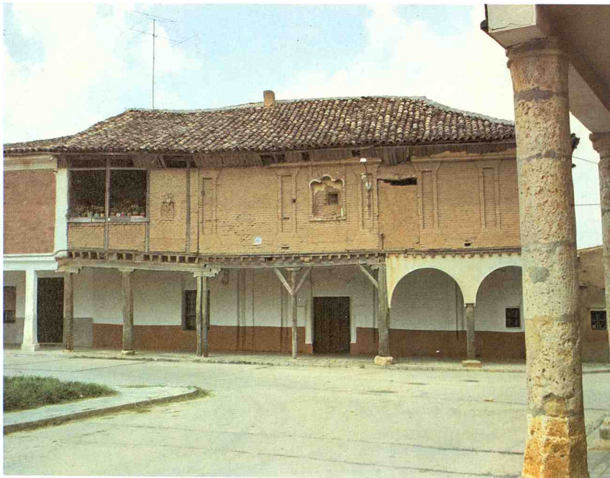
Casa típica de tapial. Villalón de Campos (Valladolid).
