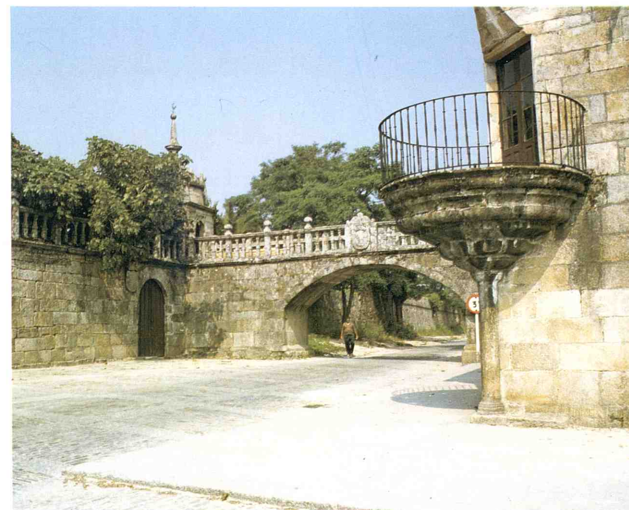
Plaza de Fefiñanes. Cambados (Pontevedra).
